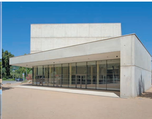
Parvis du hall d'entrée et son bandeau en Ductal®
