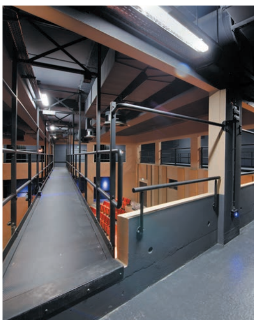
Galeries techniques, réseaux d'accès aux passerelles
