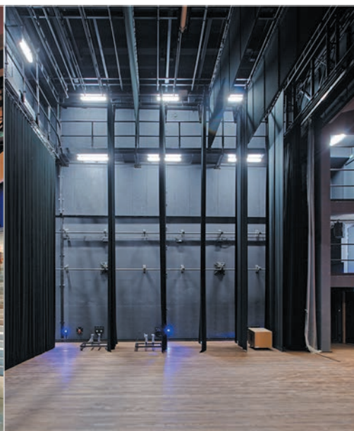
Cage de scène, passerelle et gril technique
