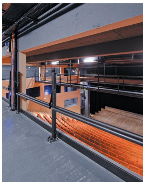
Passerelle de fond de salle, plates-formes de poursuites
